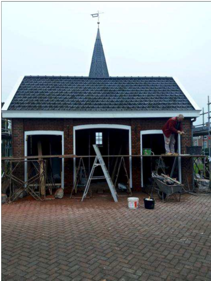
Nieuwe kozijnen en metselwerk (foto: S.H.S.)
