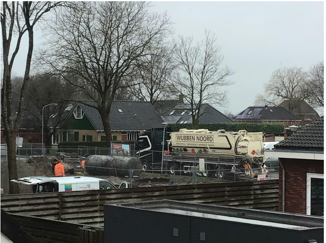
(op de foto: bodemsaneringswerkzaamheden hoek Singel - Weemweg. Foto: Birgitta Prechtl)
